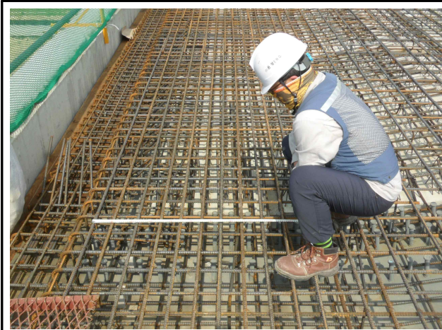
슬래브 하면(단부) 횡방향철근 간격 측정(@95)-설계@100
