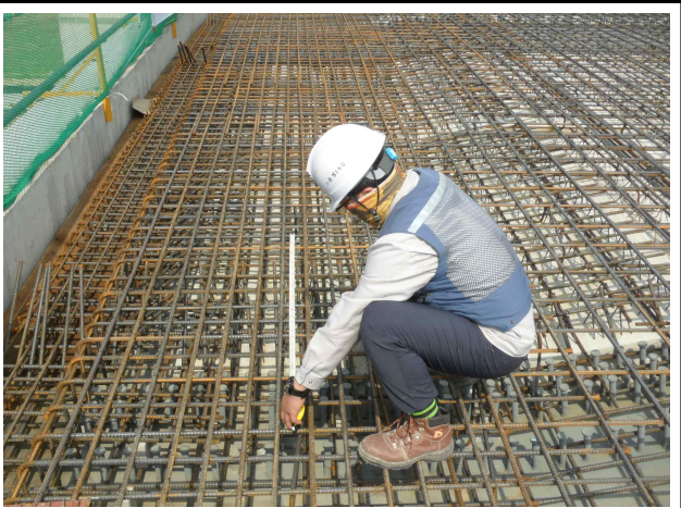
슬래브 하면(단부) 횡방향철근 간격 측정(@100)-설계@100
